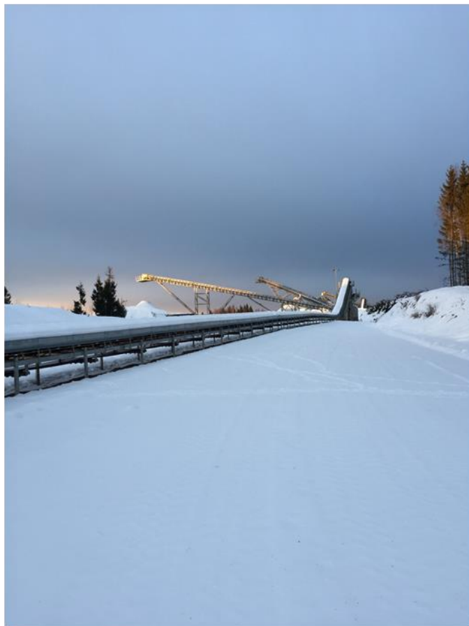
Transportbånd erstatter hjullaster
