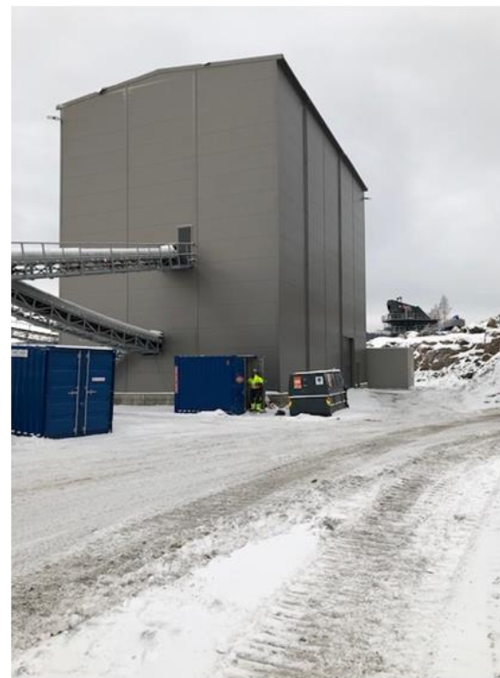
Lydisolert og støvtett bygg
