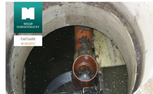
Oljeutskiller benyttes til å behandle vann som er forurenset med små mengder olje. Foto: Wenche Rudi Sævi, Miljødirektoratet.
