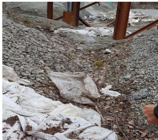
Pukkverk med ulovlig plastforsøpling
