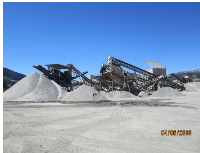
Sandtak og pukkverk i Voss kommune Foto: Fylkesmannen i Hordaland
