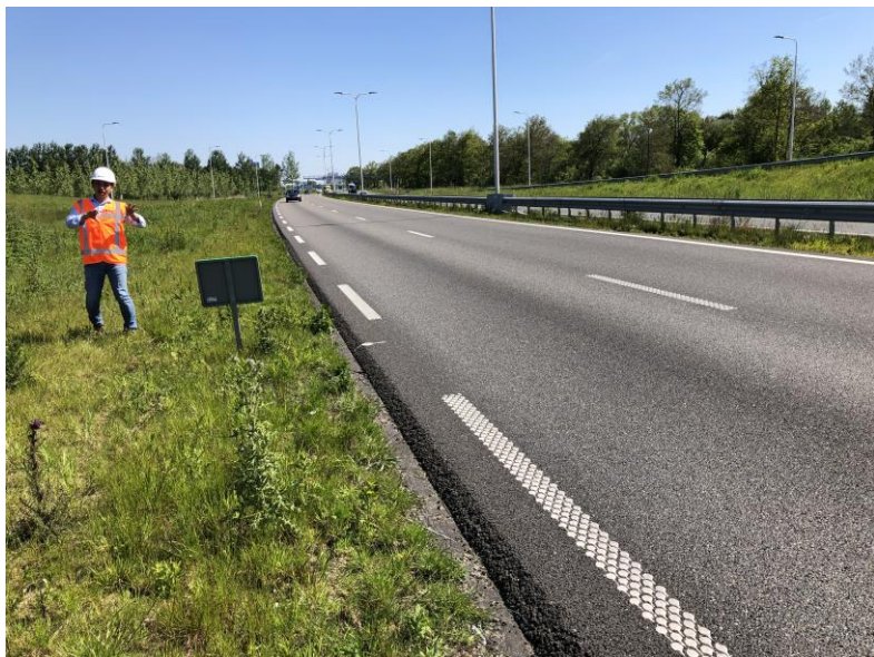
To-lags porøst dekke på motorvei 2016. 93 % RA, 110 °C
