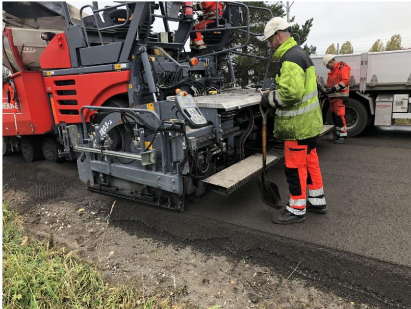
Forsterkning av vei med asfaltgranulat og geonett
