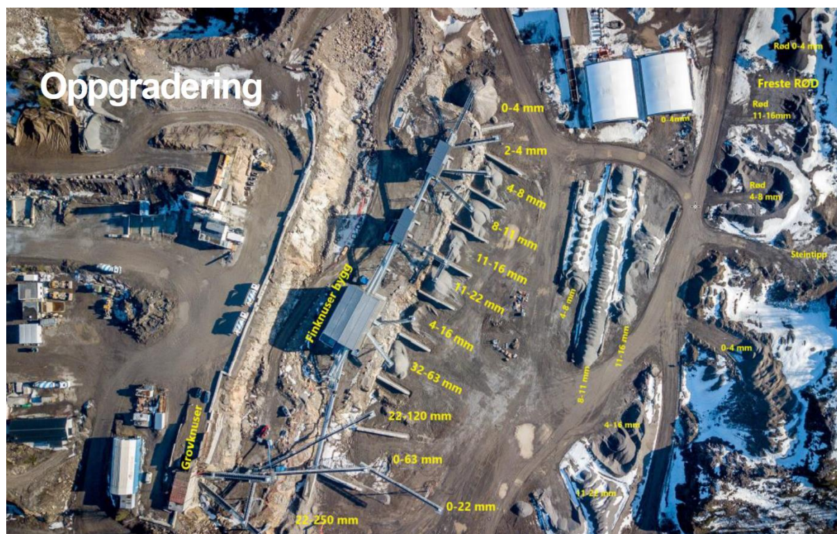
Foto fra Veidekke sitt produksjonsanlegg Freste Pukkverk nord for Tønsberg. Kilde: Veidekke AS sin presentasjon på Høstmøtet i Norsk Bergindustri 2019.
